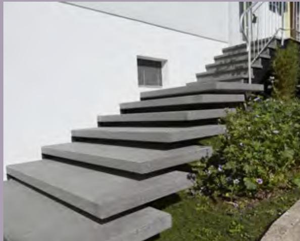
**Freitragende Stufenelemente**, wirken leicht und schwebend.
