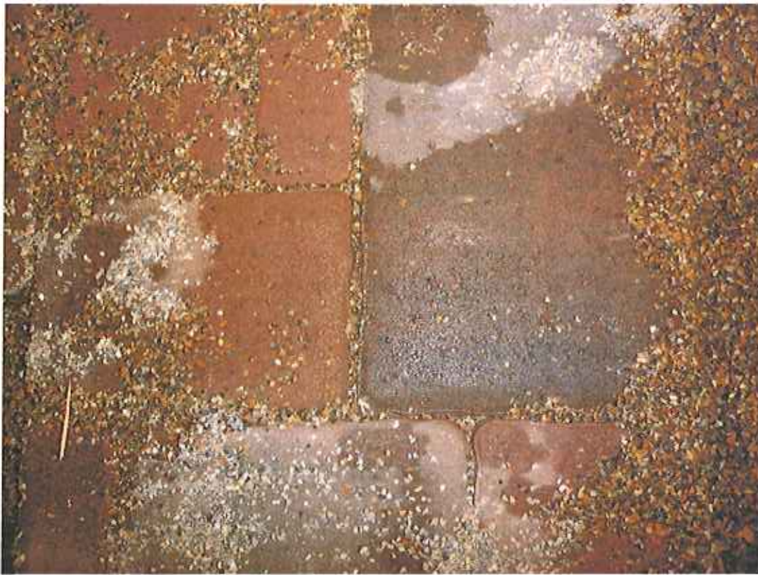
Bild 5: Draufsicht, Fuge nach Versuchsende
