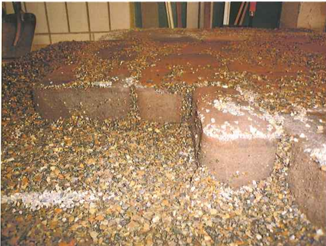
Bild 6: Detailansicht, Fuge nach Bewässerung
