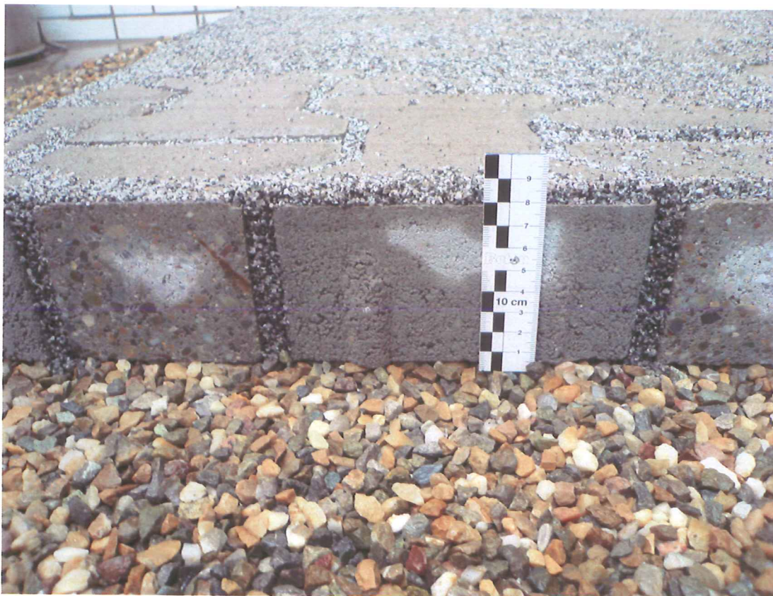
Bild 5: Detailansicht, Fuge nach Bewässerung
