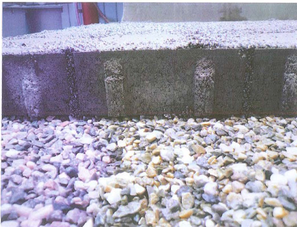
Bild 6: Detailansicht, Fuge nach Bewässerung
