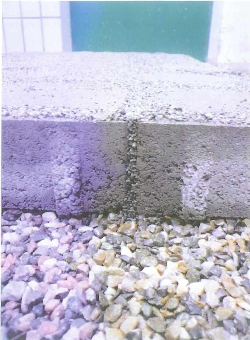
Bild 5: Detailansicht, Fuge nach Bewässerung
