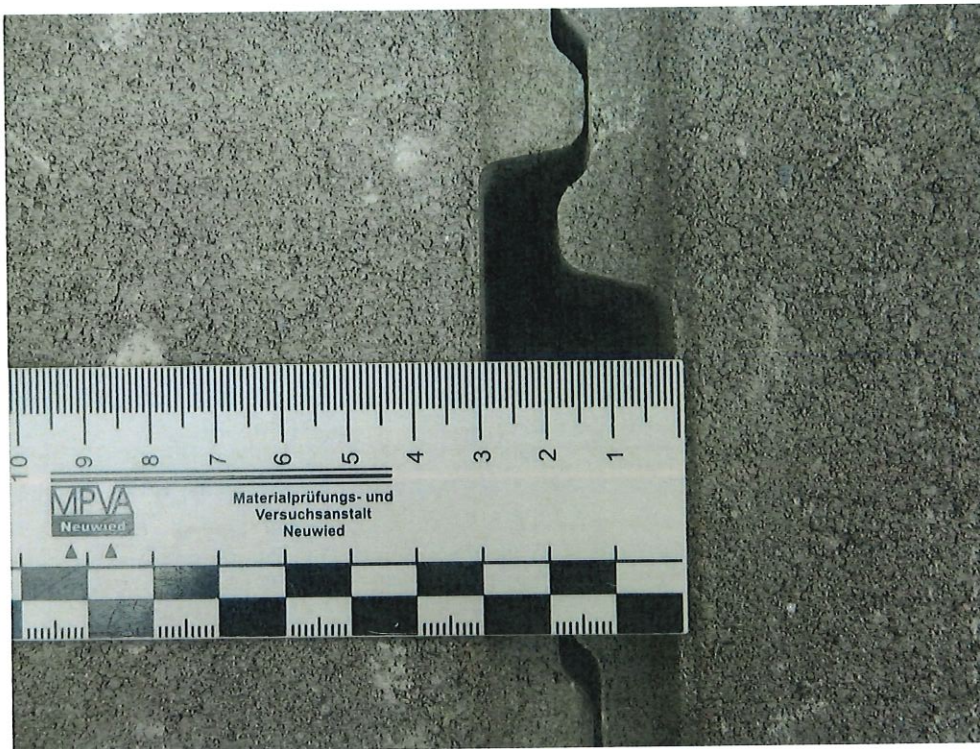
Bild 4: Resultierende Fugenbreite mit Fugenfüllung
