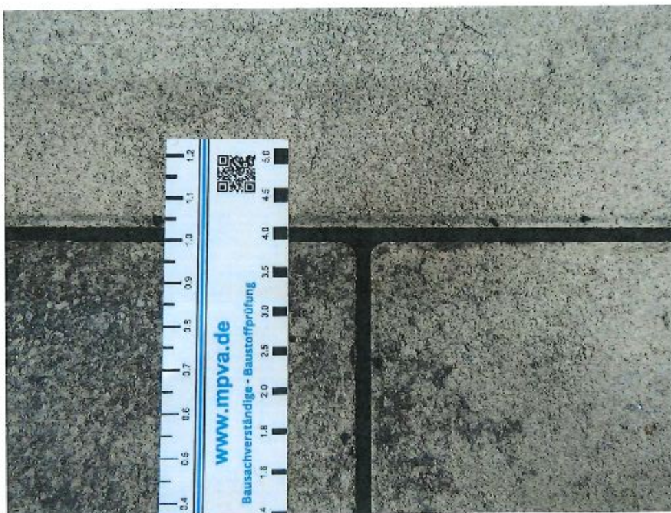
Bild 4: Resultierende Fugenbreite mit Fugenfüllung
