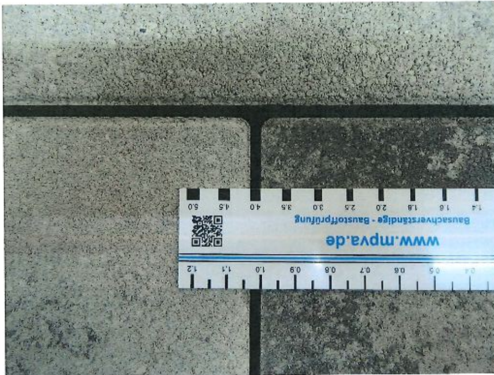
Bild 4: Resultierende Fugenbreite mit Fugenfüllung
