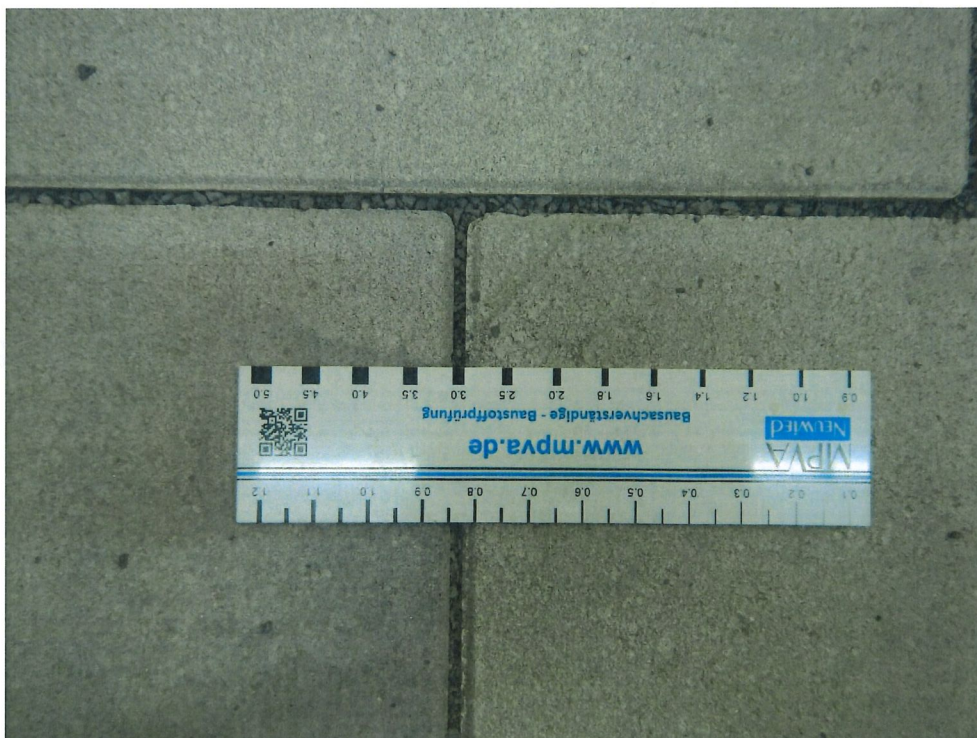
Bild 3: Resultierende Fugenbreite mit Fugenfüllung
