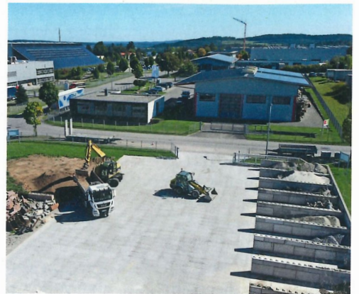
Der Lagerplatz der Grossmann Bau GmbH wurde mit einem besonders tragfähigen Pflasterbelag befestigt.
