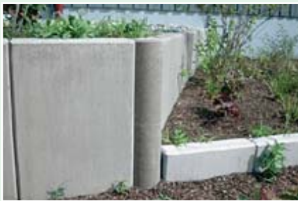
Ausführung „Sichtbeton glatt“
