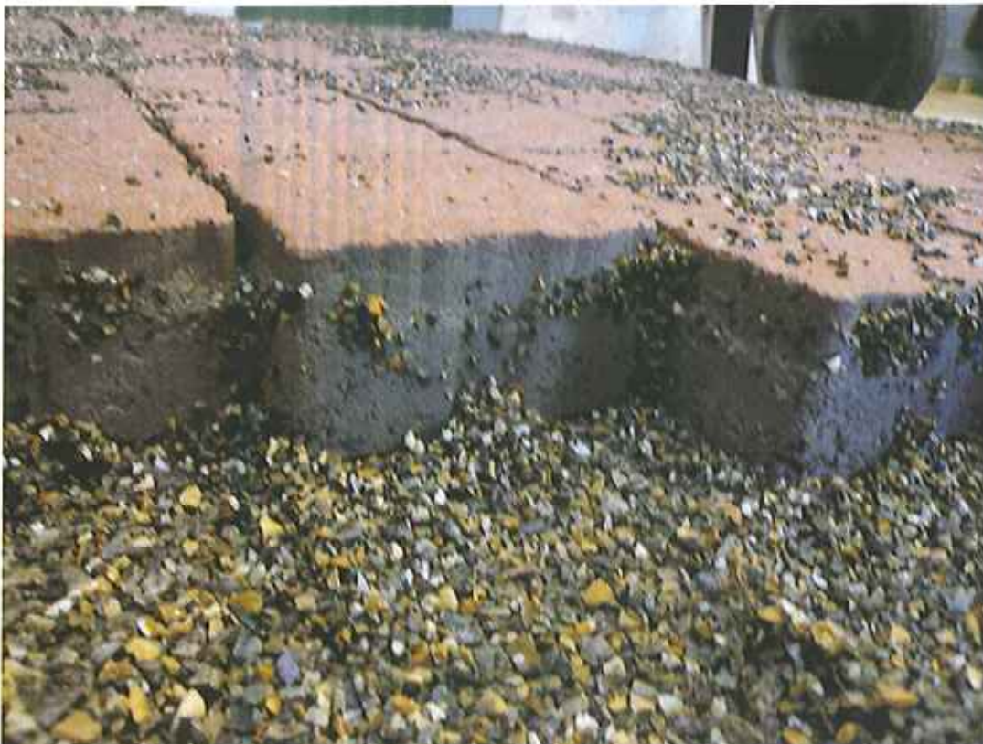
Bild 6: Detailansicht, Fuge nach Bewässerung
