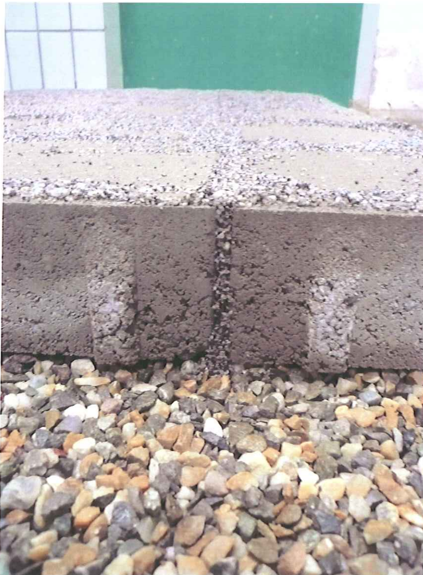
Bild 5: Detailansicht, Fuge nach Bewässerung
