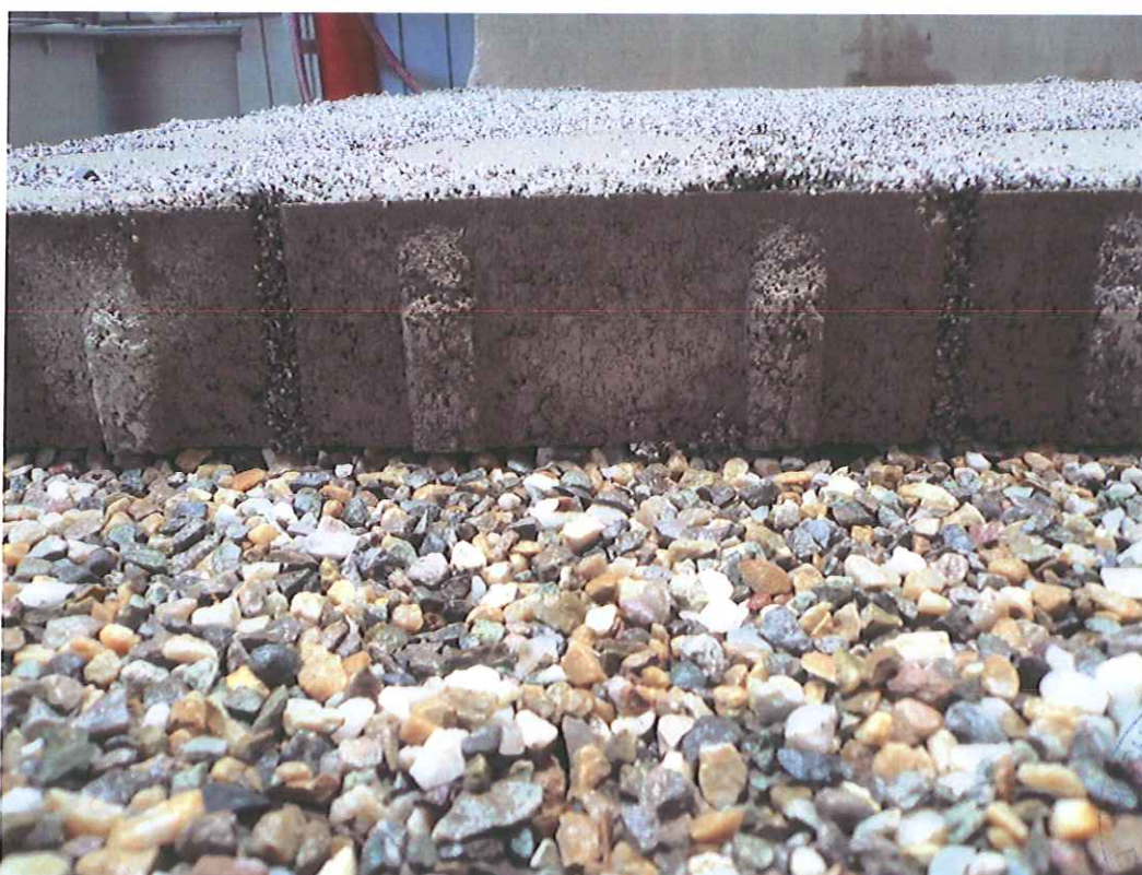
Bild 6: Detailansicht, Fuge nach Bewässerung
